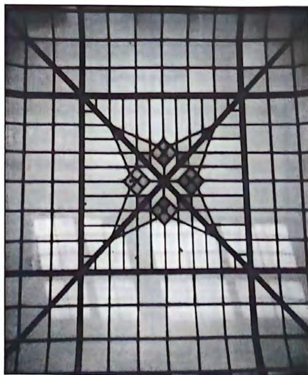
Claraboya que cierra inmueble y que supone un gran foco de iluminación cenital.
